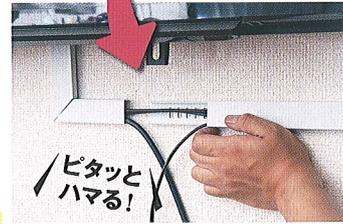
ホッチキスでモールを固定したら、カバーを付けるだけ。この際も工具を使わず取り付けられる
